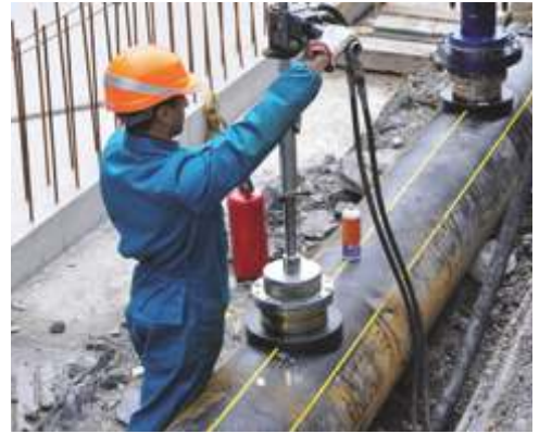
AH15 tipik boru delme/canlı hat delme ekipmanı üzerinde çalışırken
