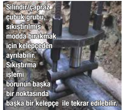
Boru sıkıştırma için pompalama işlemi
