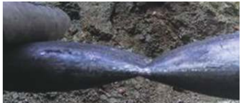
Boru sıkıştırma için pompalama işlemi
